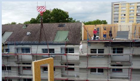
Frankfurt-Fechenheim: Aufstockung in der Dietesheimer Straße 1
